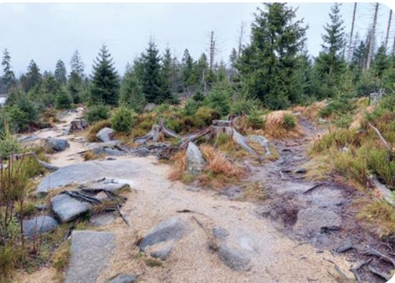
Entlang des Südostufers des Oderteichs wurde der Wanderpfad auf einer Strecke von 300 Metern u.a. mit tatkräftigem Freiwilligen-Einsatz instandgesetzt. Das Material musste hier händisch mit Schubkarren und Eimern aufgebracht werden. (Foto: K. Bauer)
