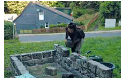
Carolin Durler beim Bau eines Hochbeetes am Nationalparkhaus Sankt Andreasberg (Foto: T. Appel)
