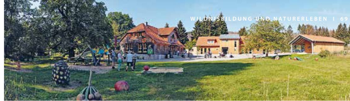
Mit der Anordnung der beiden neuen Nebengebäude wurde die ursprüngliche Form des HohneHofs als Dreiseitenhof nachempfunden (Foto: M. Gebara)
