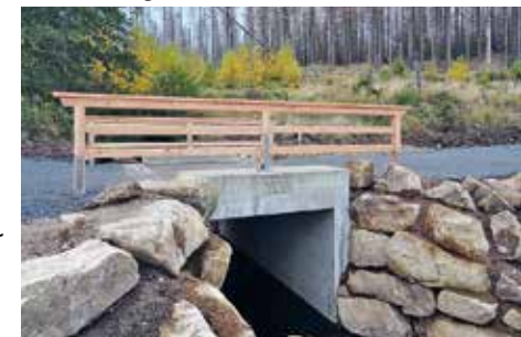
Neuer Großdurchlass am Gebbertsberg
