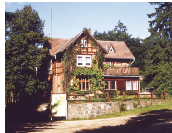
Abb. 2: Blick auf das ehemals als Biologische Station genutzte, 1907 errichtete Forsthaus Serrahn in den 1980er Jahren (Foto: H.-J. Spieß 1986).
