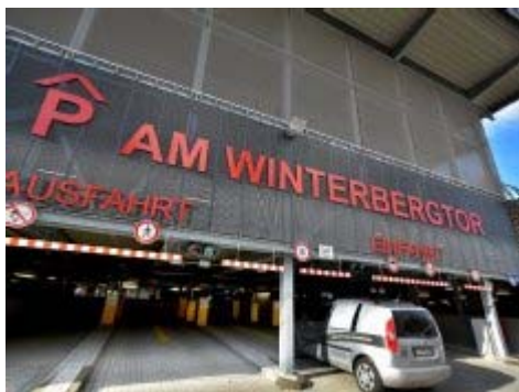
Neues Parkhaus in Schierke (BILD: FRANK DRECHSLER)
